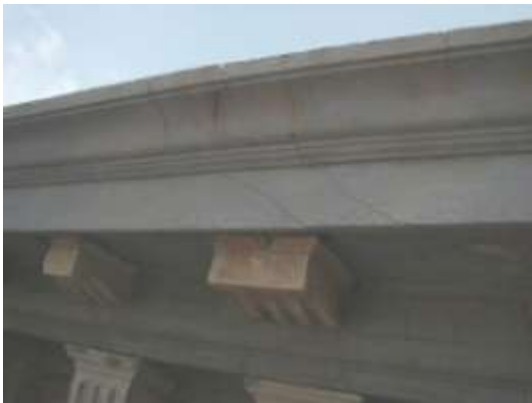
24. sz. fénykép. A koronázópárkány károsodása a francia udvarban
