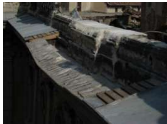
23. sz. fénykép. A koronázópárkány burkolata helyenként laza.
