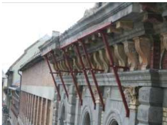
7. sz. fénykép. Felső erdősor utca felőli külső párkány konzolos gyámolítása
