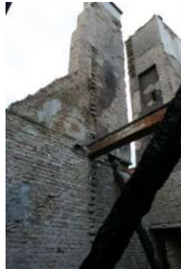
14. sz. fénykép. Kettős I tartók a tűzgátló falak helyén (alul egy darab a falból még látható). Csorbázás a légudvar falában
