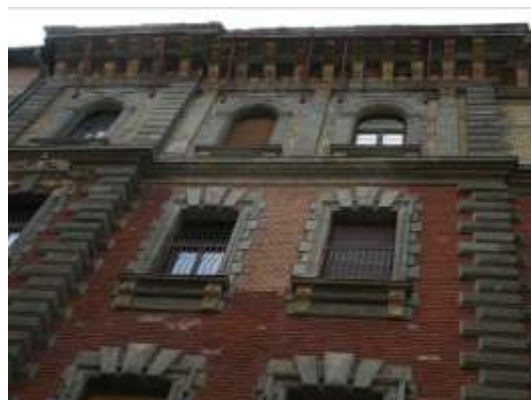
7. sz. fénykép. Felső erdősor utca felőli külső párkány konzolos gyámolítása
