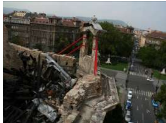
6. sz. fénykép. A sarki oromdíszek stabilizálása
