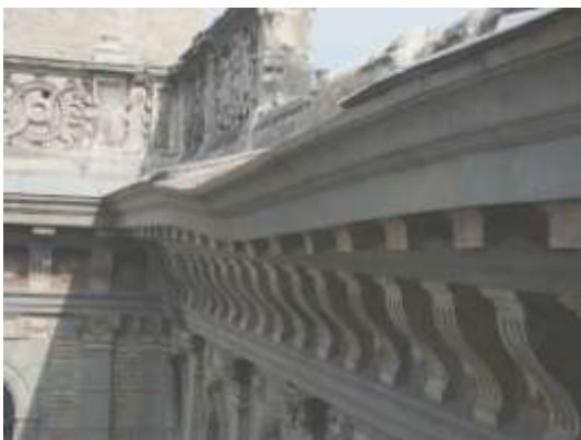
23. sz. fénykép. A koronázópárkány burkolata helyenként laza.
