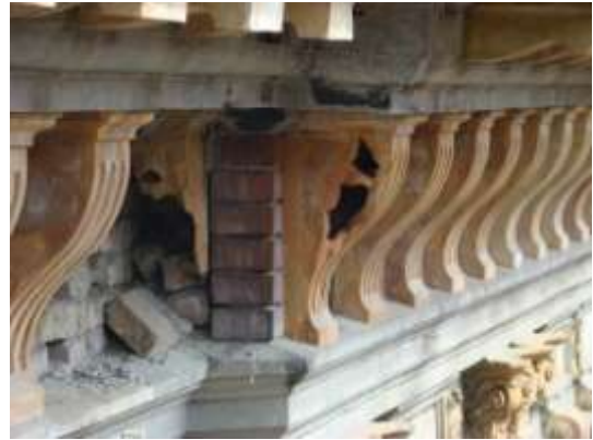
23. sz. fénykép. A koronázópárkány burkolata helyenként laza.
