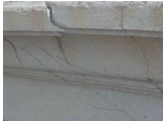
24. sz. fénykép. A koronázópárkány károsodása a francia udvarban
