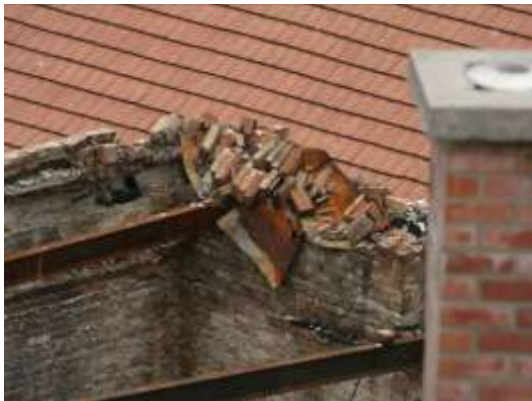
24. sz. fénykép. A koronázópárkány károsodása a francia udvarban
