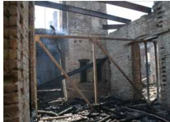
22. sz. fénykép. Főfalak. A rácsos „vonószerkezet”
