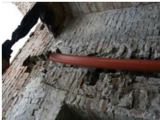
12. sz. fénykép. Az attikacsatorna maradványai. Épen maradt párkányok a tornyokon. Megégett ejtőcsövek az épületen belül
