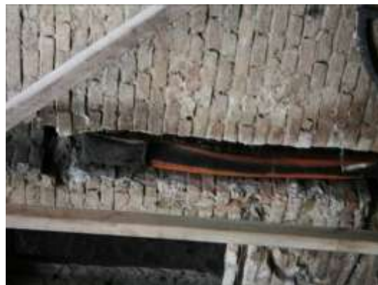
12. sz. fénykép. Az attikacsatorna maradványai. Épen maradt párkányok a tornyokon. Megégett ejtőcsövek az épületen belül
