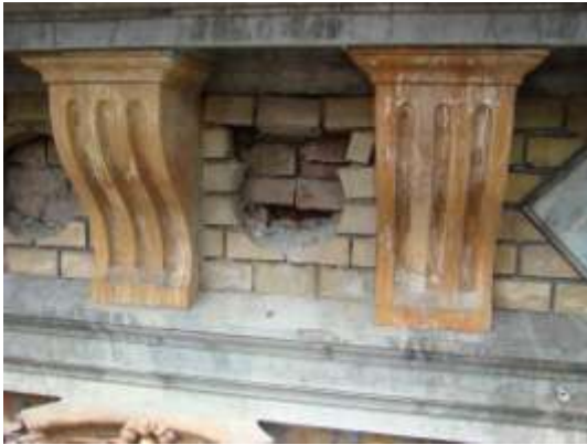
23. sz. fénykép. A koronázópárkány burkolata helyenként laza.
