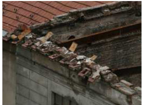
24. sz. fénykép. A koronázópárkány károsodása a francia udvarban
