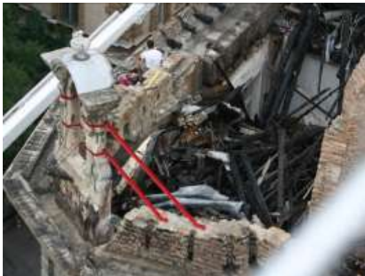
6. sz. fénykép. A sarki oromdíszek stabilizálása
