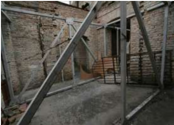
22. sz. fénykép. Főfalak. A rácsos „vonószerkezet”
