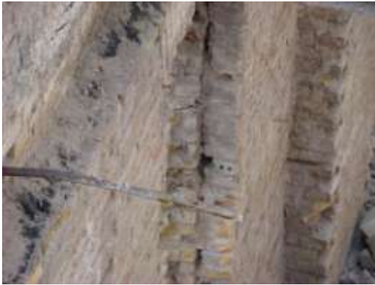
21. sz. fénykép. Az acélgerendán rögzített fa járószint maradványai. Födémgerenda végéből kiszakadt rögzítő-bekötő vas
