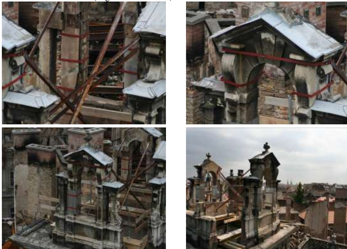
9. sz. fénykép. A tornyokban lévő oromdíszek stabilizálása
