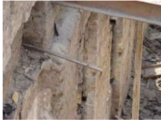
21. sz. fénykép. Az acélgerendán rögzített fa járószint maradványai. Födémgerenda végéből kiszakadt rögzítő-bekötő vas
