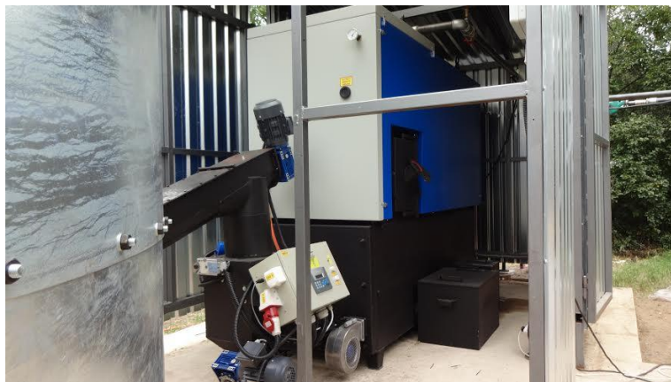
2. kép: IRSA-THERM 150 "A" típusú kazán (Forrás:[9])
