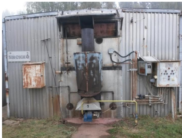
1. kép: Gáz léghevítő, nedvesítő csomók, szellőztető zsalu (Forrás: Saját készítés)
