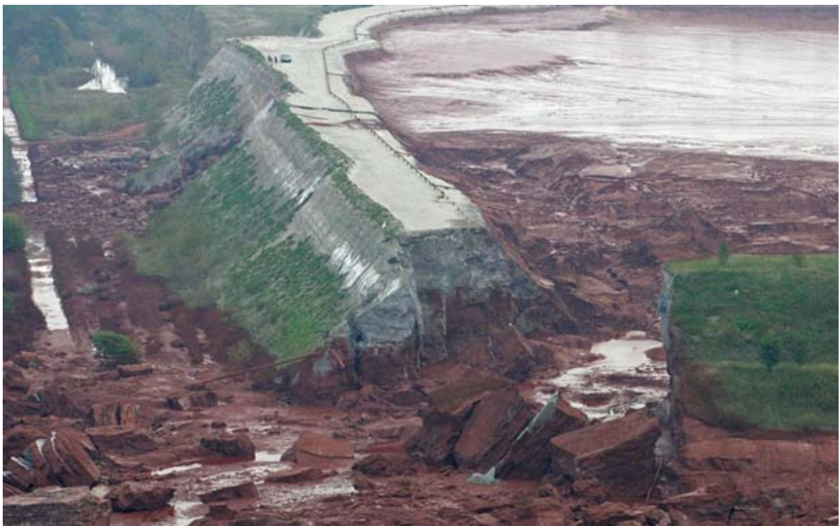
4. ábra MAL Zrt. X. kazetta a gátszakadás után (Foto: Varga György / MTI)
