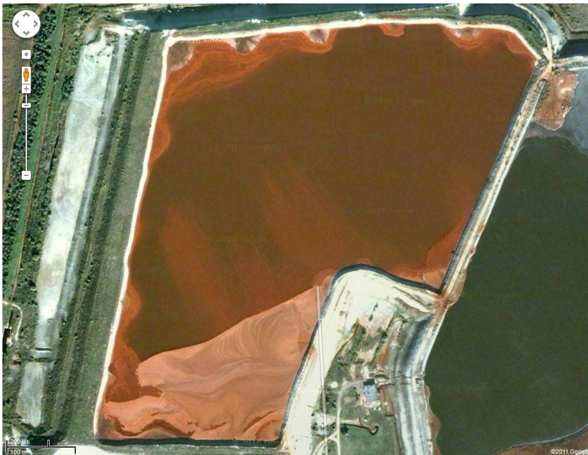
2. ábra Ajka X. sz. zagyártoló kazetta szatellit-képe a gátszakadás előtti állapotban (Google, – Szanyi János Szeged, JATE közreműködésével másolva – Kolontár_1. JPG)
