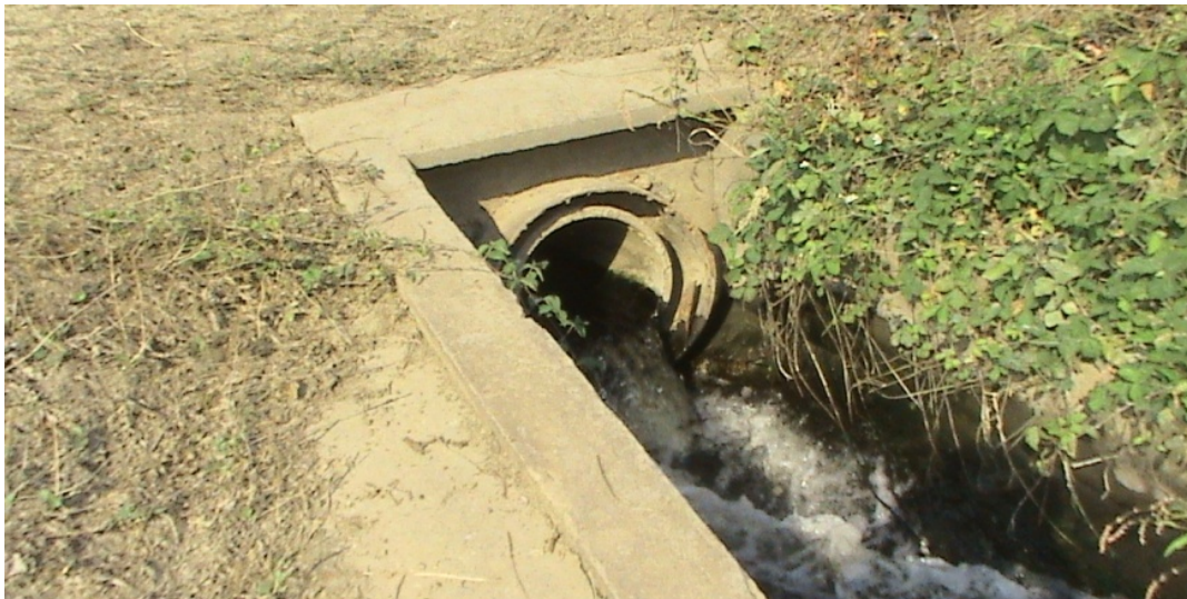
4. kép A tisztított szennyvíz Berettyóba vezetése (saját fotó)
