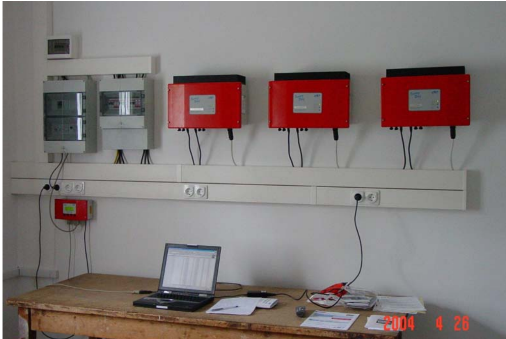
1. ábra Sunny Boy Control (SB 2500) inverterek
